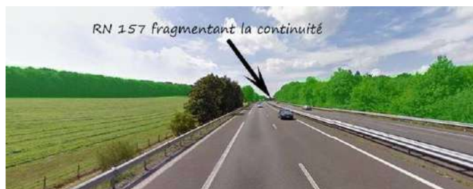
Discontinuité le long de la RN 157
