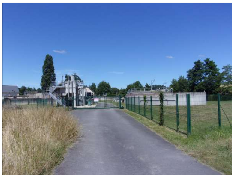
Vue de la station d'épuration du SIVOM de la SAVATRAIS
