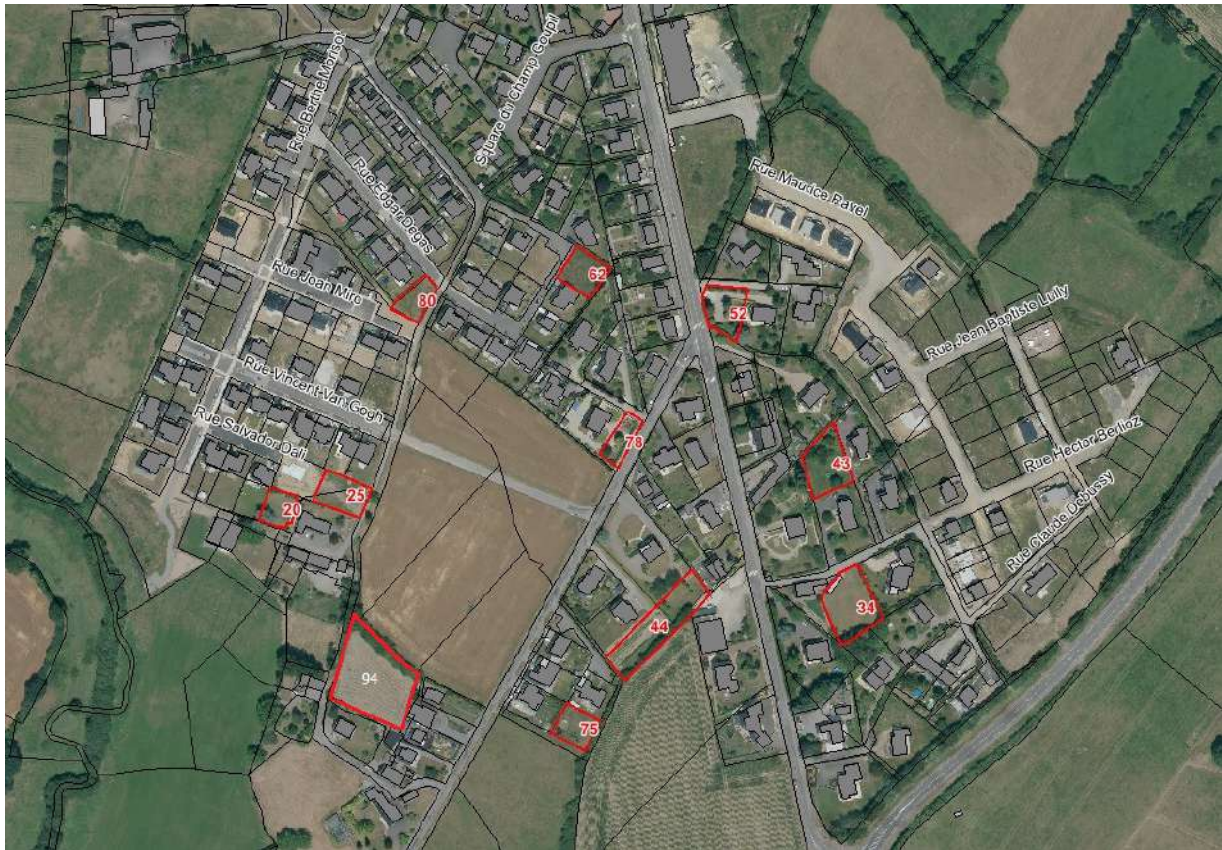
Partie sud du bourg
