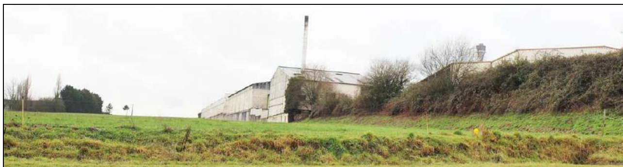
Arrière des bâtiments : absence d'intégration paysagère et d'articulation avec les espaces agricoles.
