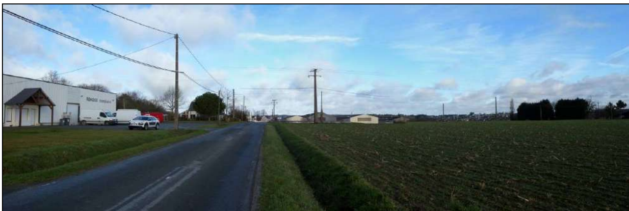
Bâtiments d'exploitation sans qualité architecturale, ni intégration, mettant à mal la relation entre le bourg et son paysage.
