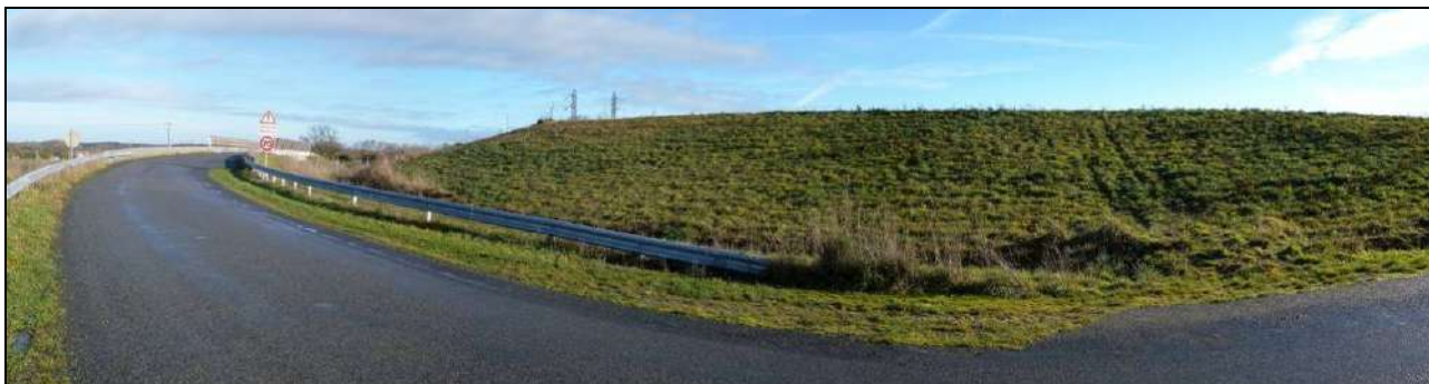
Remblais empêchant la vue, non-traité, et impactant le paysage de campagne.
