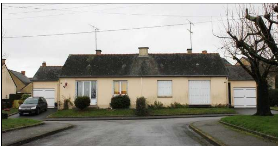
Opération ancienne de maisons jumelées.
